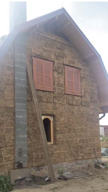
Dom ekologiczny Zbyszka Ściany w Marszewie wykonany w technologii gliniano-słomianej
